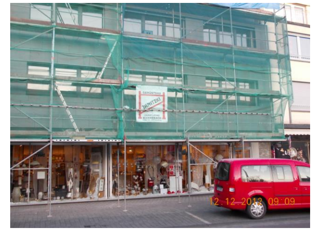
Abbildung 13: In Zusammenhang mit der Bautätigkeit stehende Werbung auf Baugerüsten
