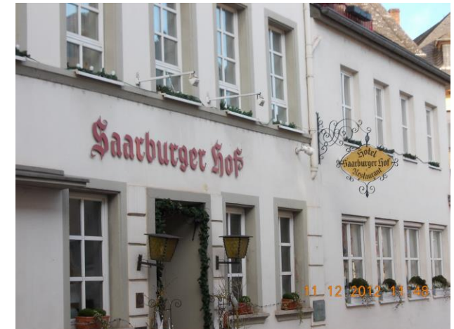
Abbildung 3: unzulässige Vielzahl an Werbeanlagen an Fassadenflächen
