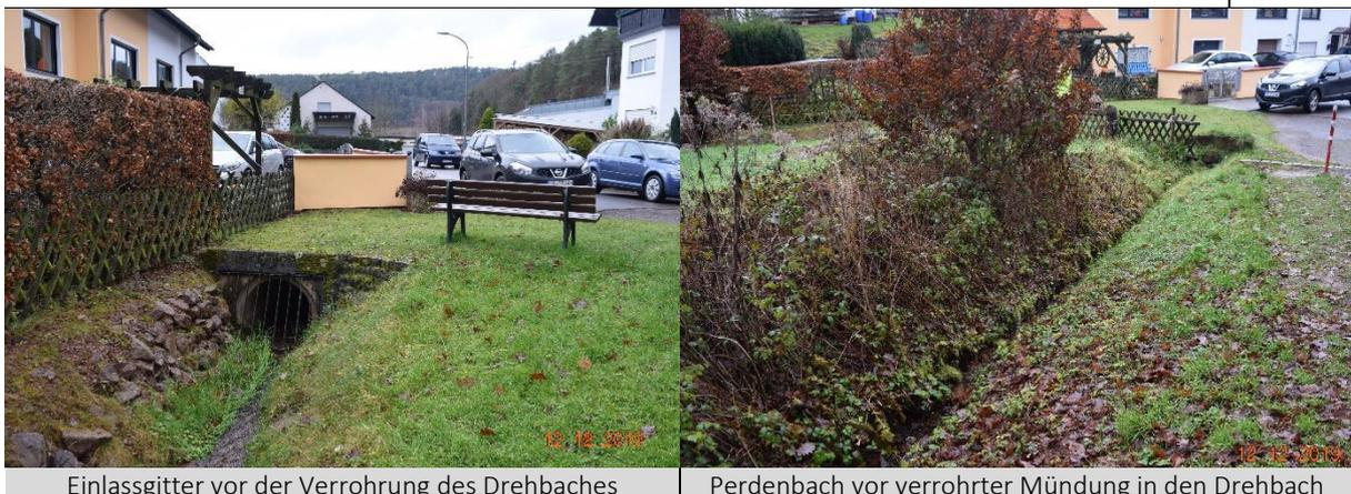
Der Drehbach ist ein Gewässer 3. Ordnung und verläuft im Ortsteil Perdenbach innerhalb der Bebauung teilweise verrohrt. Ihm wird – ebenfalls verrohrt – der Perdenbach, oberhalb der Bebauung, zugeführt. In einem kurzen Abschnitt fließt das Gewässer im Anschluss offen auf Privatgrundstücken, bevor es nach einer kurzen Strecke unter der Mühlenstraße offen in die Leuk mündet. Der tatsächliche Verlauf des Baches folgt nicht dem im Geoportal dargestellten Verlaufs.
