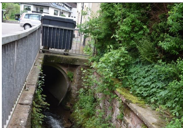
Verrohrung Breinsbach in der Hauptstraße
