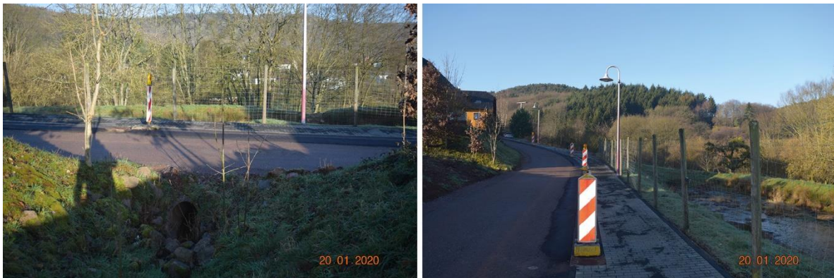
Abb. 9: Durchlass der Entwässerungsmulde und Straße „Weierfeld“ am Rückhaltebecken
