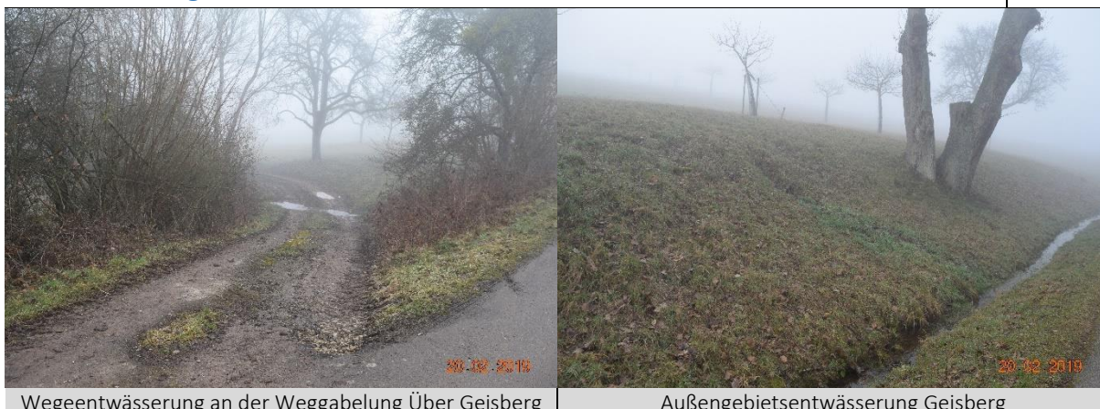
Wegeentwässerung an der Weggabelung Über Geisberg
