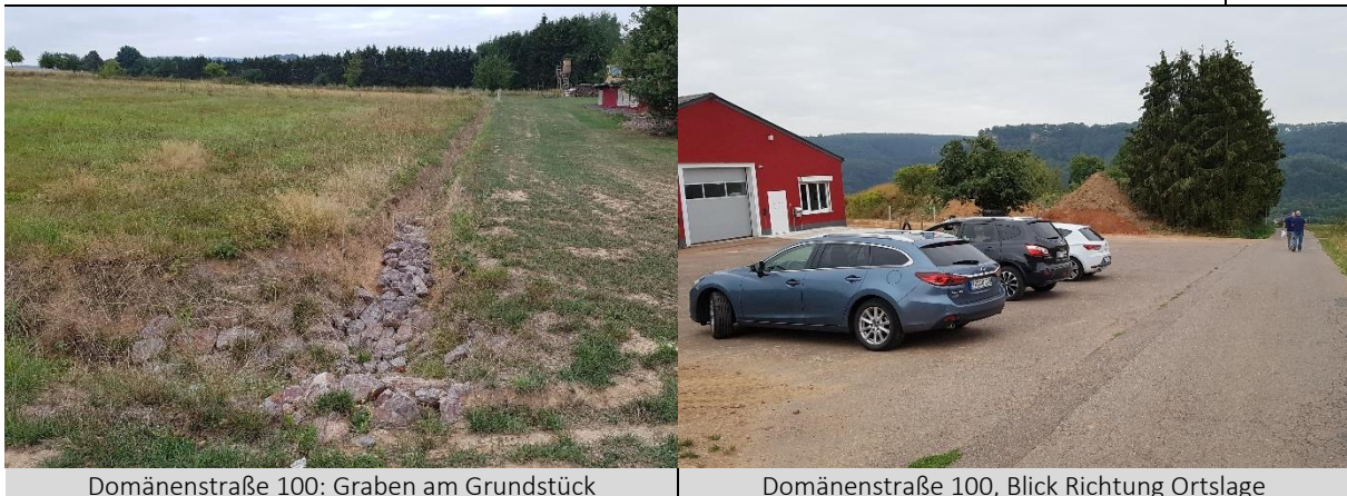
Domänenstraße 100: Graben am Grundstück
