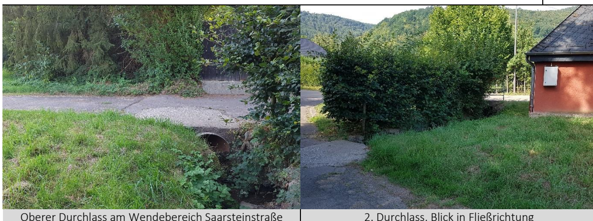
Oberer Durchlass am Wendebereich Saarsteinstraße
