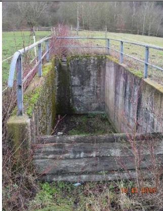
Einlassbauwerk des Gewässers
