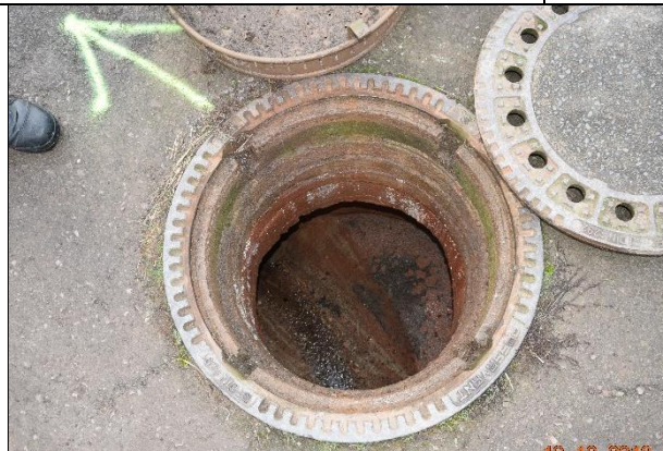
Kanalschacht mit vermuteter Umleitung des Gewässers
