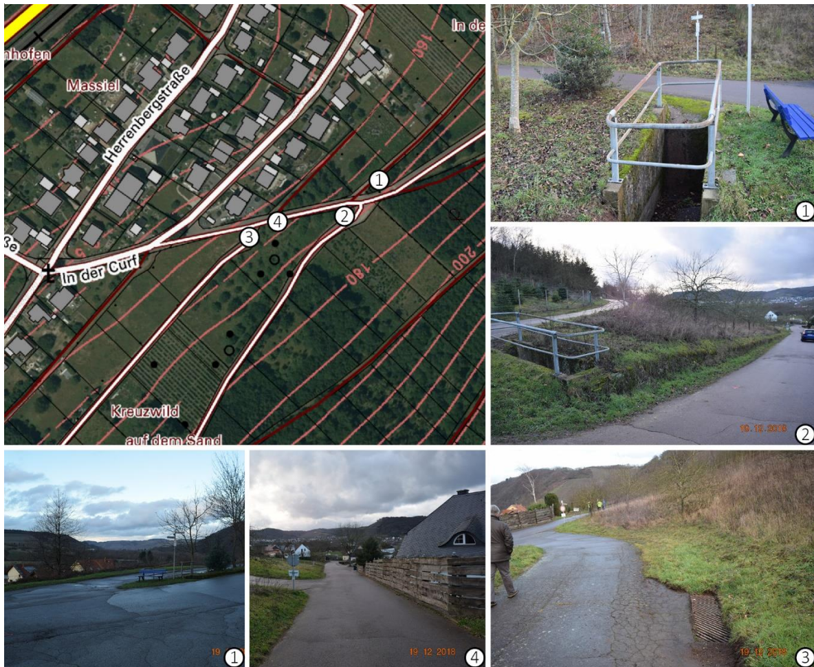
Abb. 13: Einlassbauwerke im Außengebiet „In der Curf“
