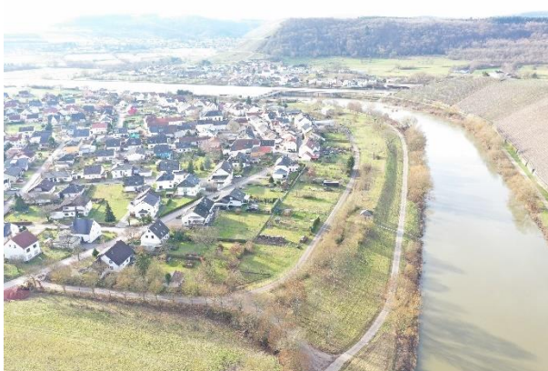
Blick auf den Deich entgegen der Fließrichtung
