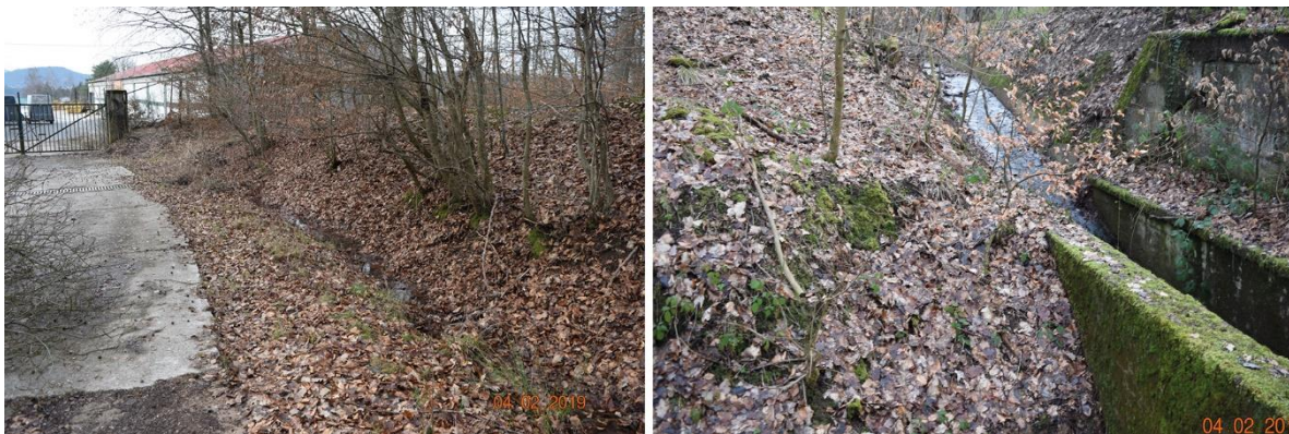
Abb. 36: Entwasserung und Einlassbauwerk an der ehemaligen Panzerstrae
