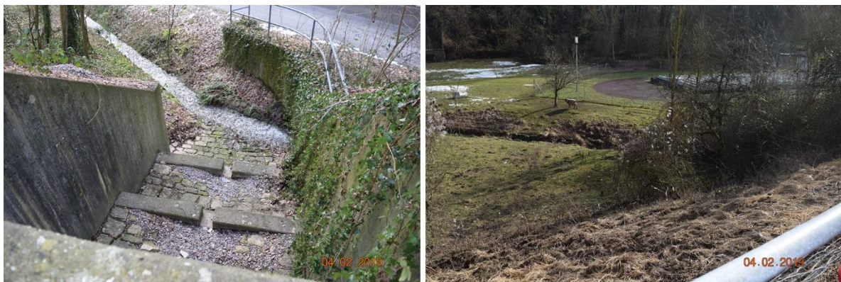
Abb. 42: Grundbach-Bauwerk „In den Urlaub“ und Mischwasseranlage am Grundbach
