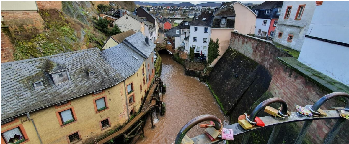
Abb. 28: Gefährdete Objekte zwischen Wasserfall und Laurentiusbrücke
