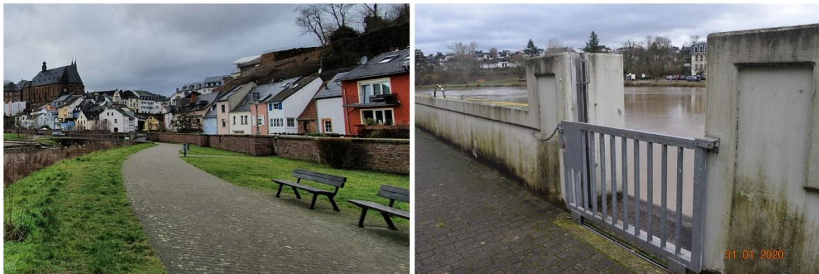
Abb. 22: Schutzmauer an der Leukbachmündung (links) und mobiler Hochwasserschutz im „Staden“
