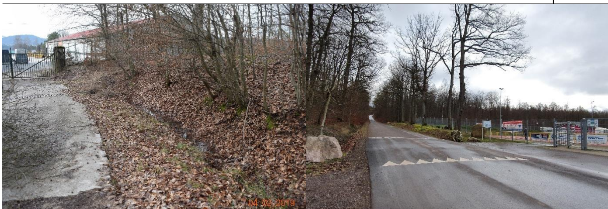
Entwässerung an der Panzerstraße Richtung Kaserne
