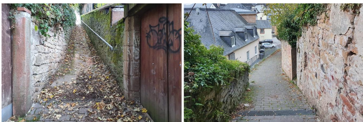
Abb. 29: Entwässerungsrinne im Fußweg zum „Fruchtmarkt“/ Bereich „Kunoweier“
