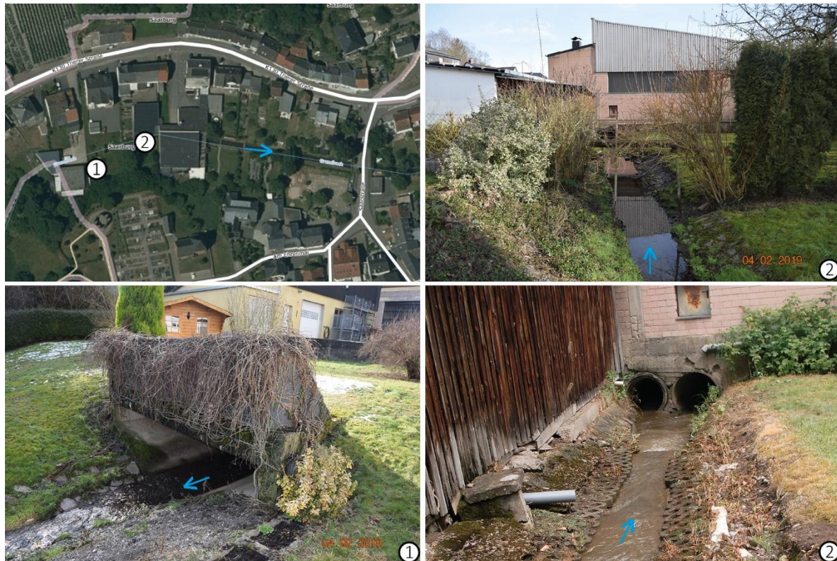
Abb. 44: Verrohrungen/ Durchlassbauwerke am Grundbach im Bereich Trierer Straße 19 und 29
