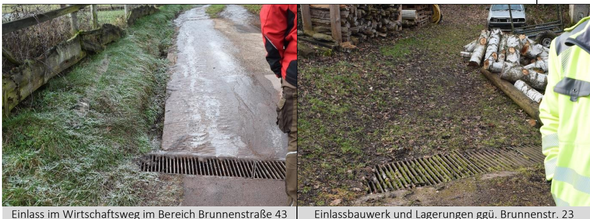
Einlass im Wirtschaftsweg im Bereich Brunnenstraße 43
