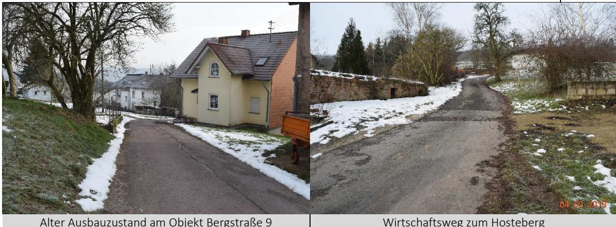
Alter Ausbauzustand am Objekt Bergstraße 9
