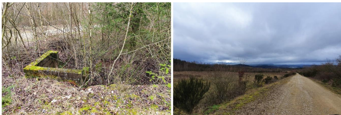
Abb. 37: Alte Entwasserungseinrichtungen auf dem ehemaligen Truppenubungsgelande
