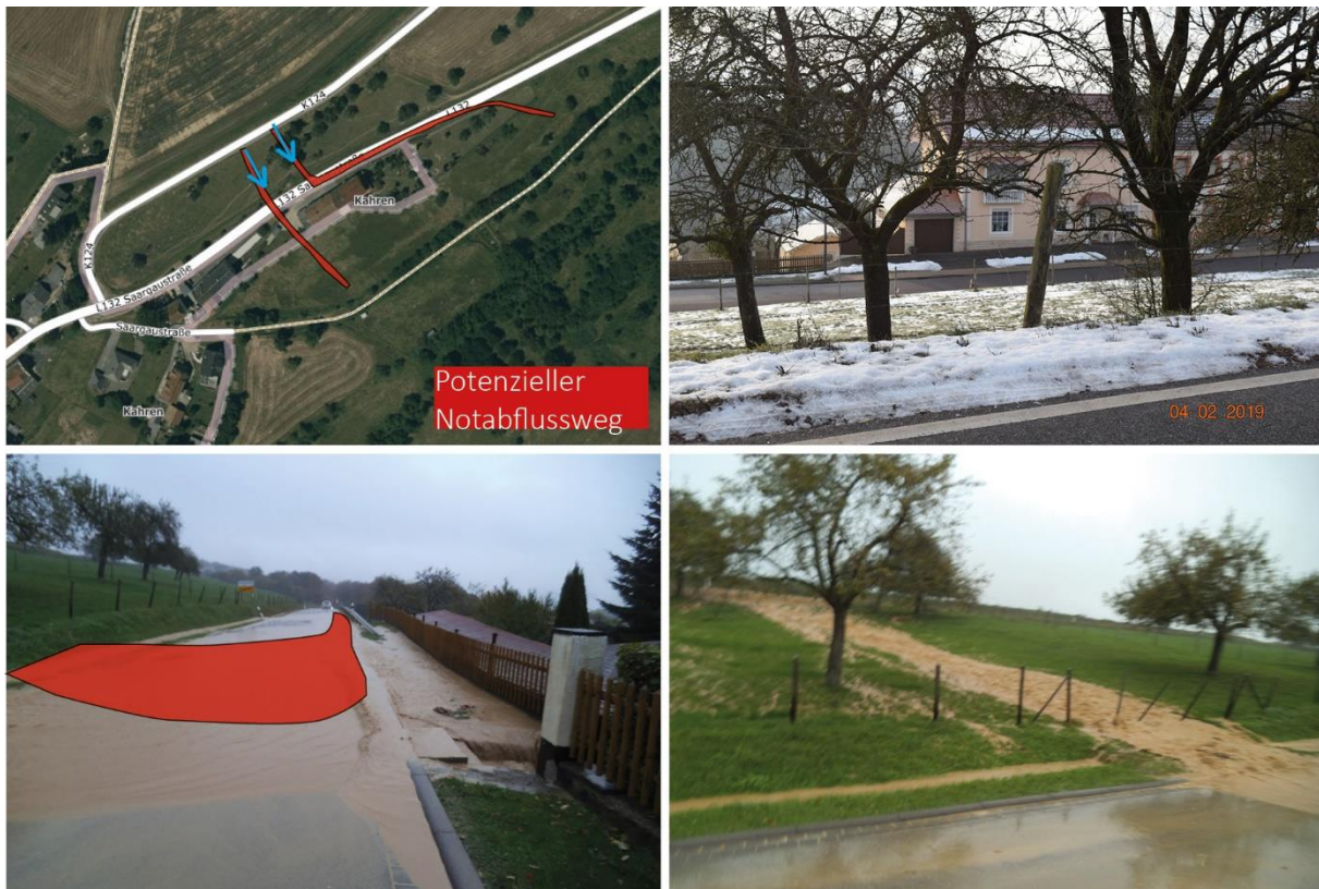
Abb. 38. Potenzielle Notabflusswege K 124 bis in das Mandelbachtal
