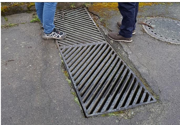
Einlassrost am Weg in Verlängerung der Bocksteinstraße
