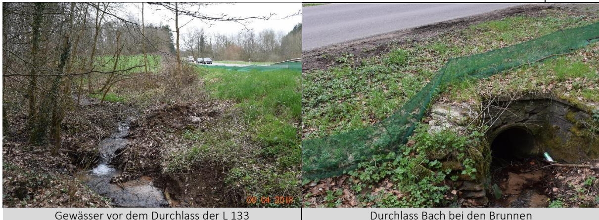
Gewässer vor dem Durchlass der L 133
