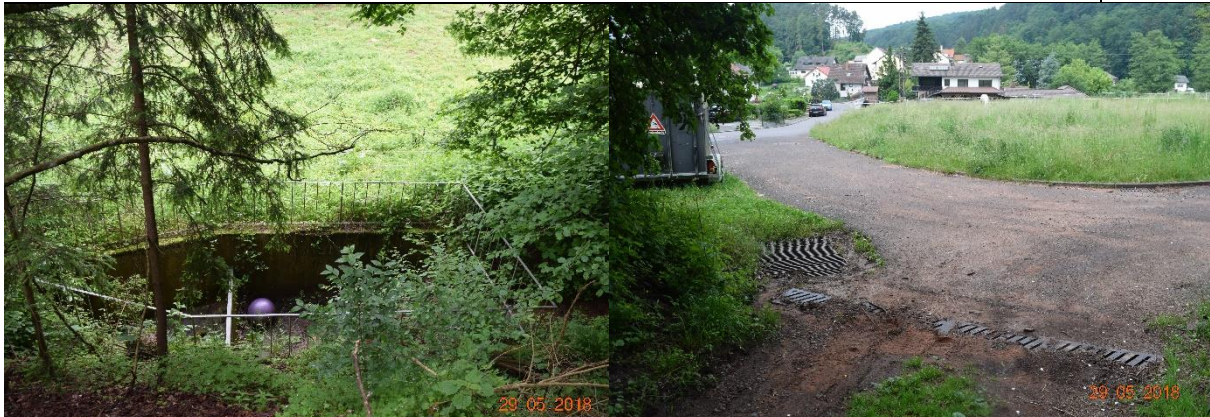
Einlassbauwerk Kallesgraben am „Alten Weg“
