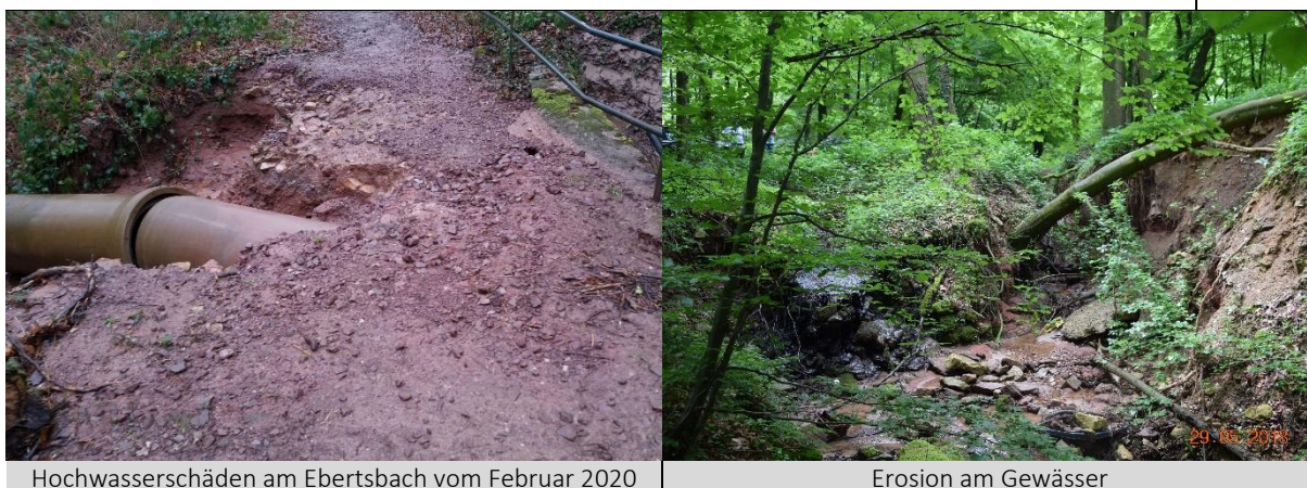
Hochwasserschäden am Ebertsbach vom Februar 2020
