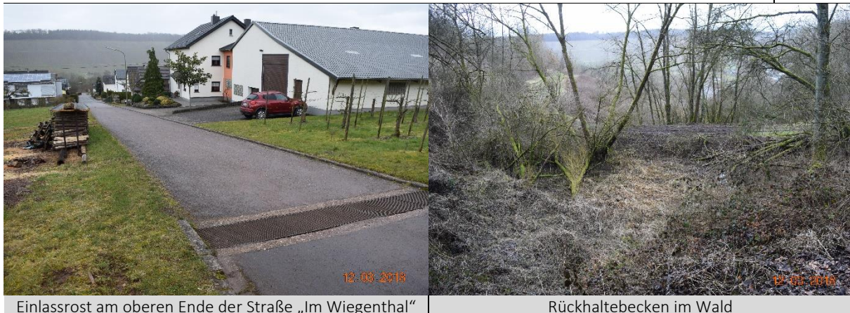
Einlassrost am oberen Ende der Straße „Im Wiegenthal“
