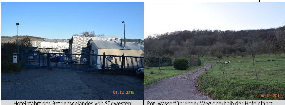
Hofeinfahrt des Betriebsgeländes von Südwesten
