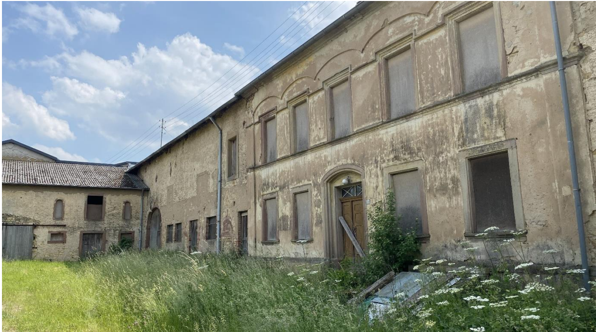
Abbildung 8: Bsp. Leerstand in Wincheringen Im Weissfeld
