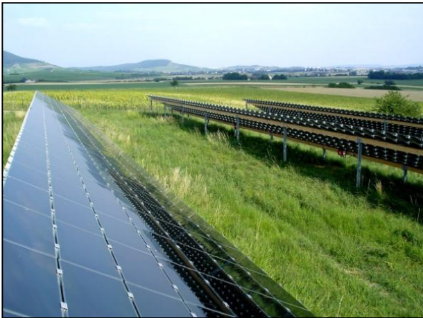
Beispiel für eine aufgeständerte Anlage mit Unterwuchs
