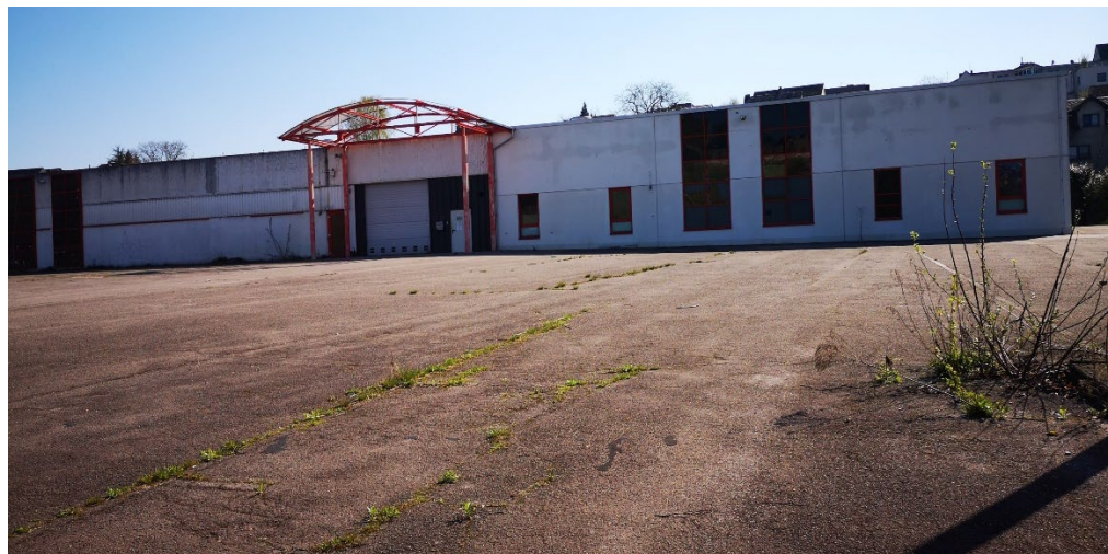
Abbildung 7: Blick auf den aktuellen Bestand. Vorderer Bereich sind vollversiegelte Verkehrsflächen. Im hinteren Abschnitt ist der ehemalige TOOM-Einkaufsmarkt zu erkennen.
