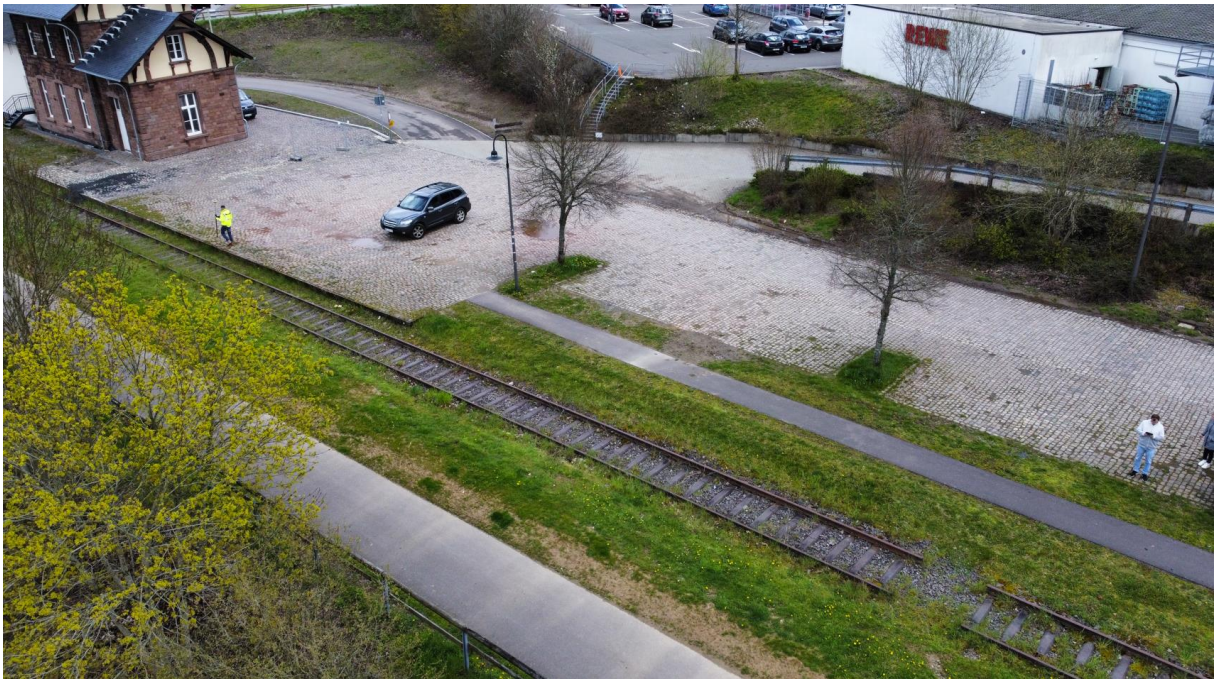
Abb. 3: Drohnenaufnahme des Plangebietes, Blickrichtung Nordost, o.M. (Quelle: P & P GmbH).
