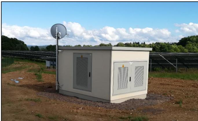
Abb. 2: Beispiel für eine Trafostation (Foto: BGHplan Juni 2017)
