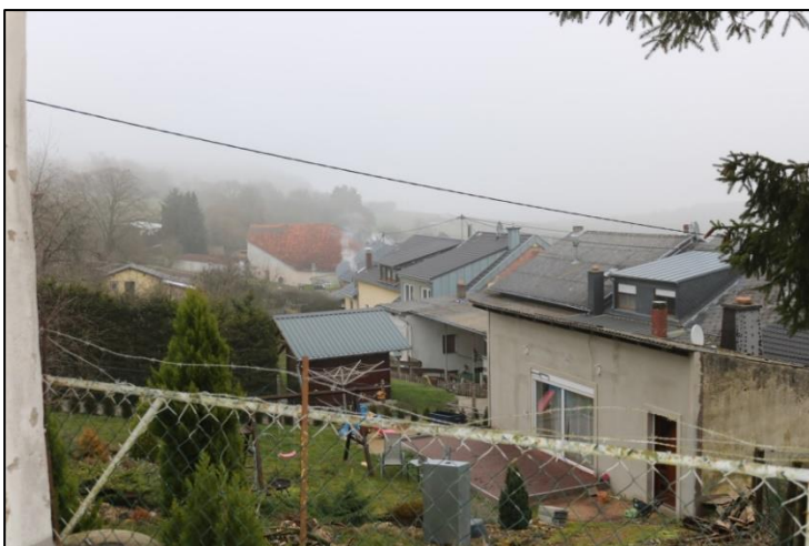
Abb. 4: Hanglage auf der Westseite der Kapellenstraße – Rückseite der Anwesen - , Südlicher Teil
