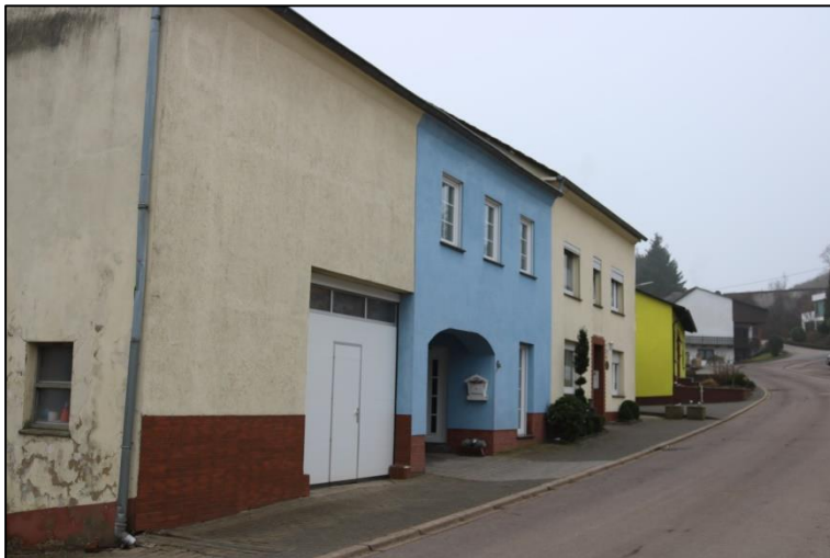
Abb. 6: Blick in die Kapellenstraße von Norden nach Süden zur Ostseite
