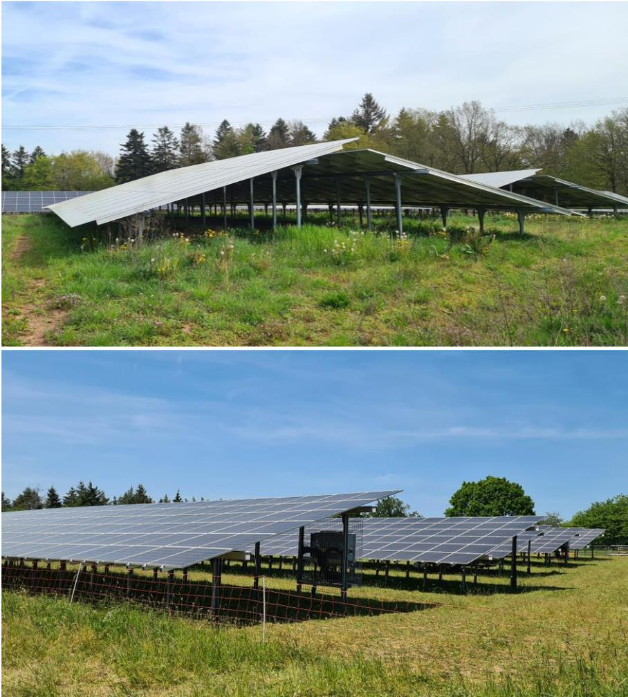
Abb. 2: Beispiel einer Ost-West ausgerichteten Freiflächenanlage (oben) und einer nach Süden ausgerichteten Freiflächenanlage (unten), (Fotos: BGHplan).
