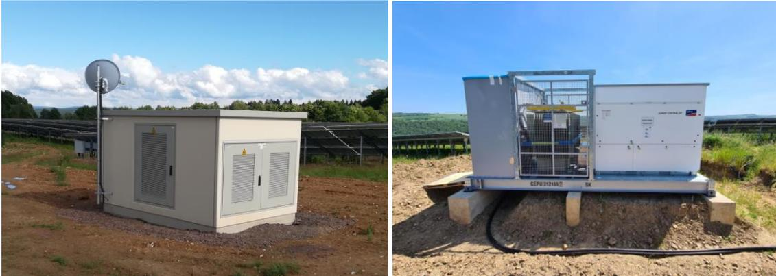
Abb. 3: Beispielhafte Trafostation als Kompaktstation auf einer Freiflächenanlage (links) und Kombistation mit Trafo, Wechselrichter und Schaltanlage auf Streifenfundamenten (rechts)
