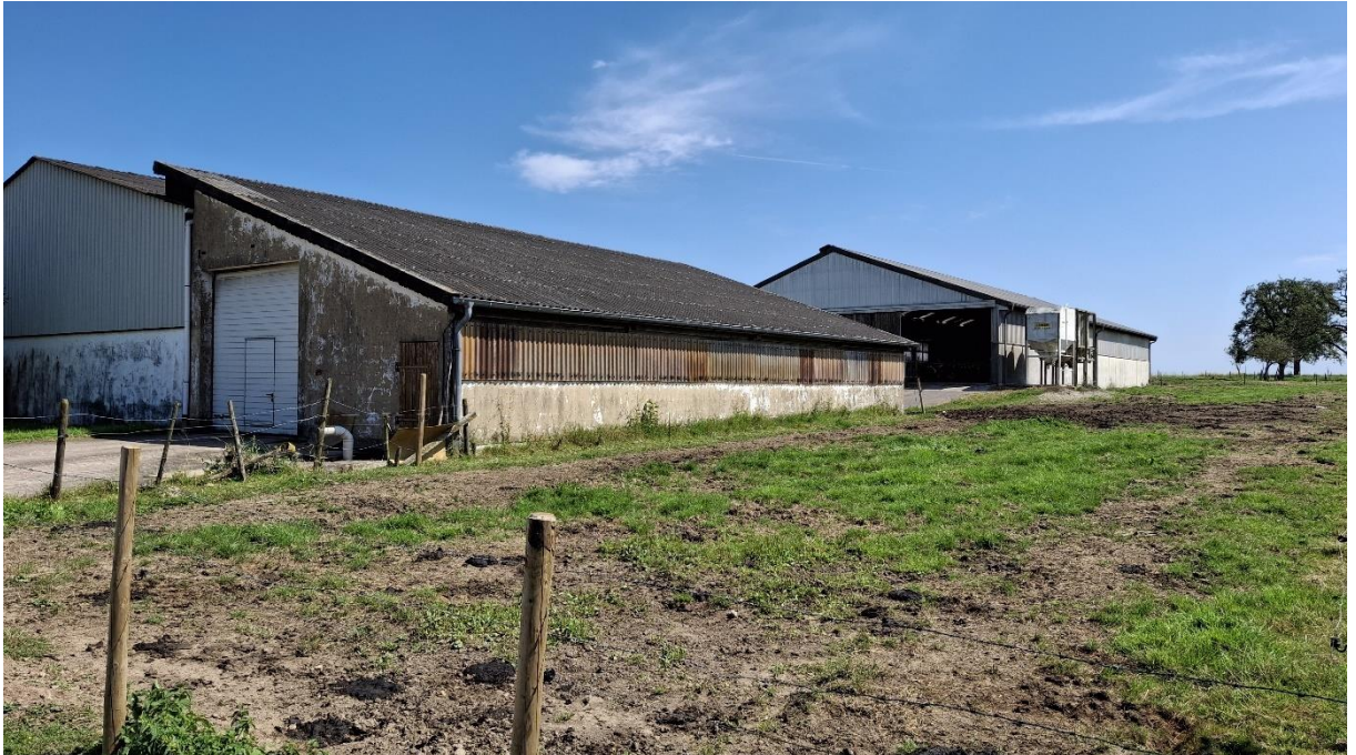
Abb. 6: Blick auf die Stallungen des Bauernhofes östlich des Plangebiets.
