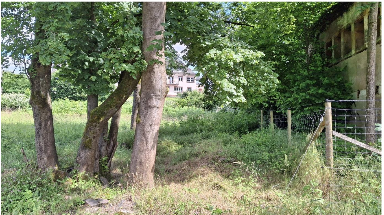
Abb. 4: Denkmalgeschütztes Gerberhaus rechts, Aufnahme: Ingenieurbüro Paulus & Partner.
