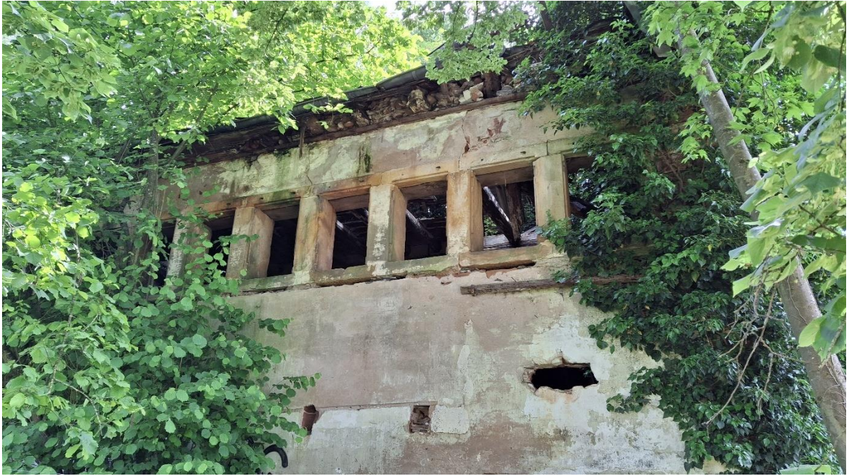
Abb. 5: Denkmalgeschütztes Gerberhaus, Aufnahme: Ingenieurbüro Paulus & Partner.
